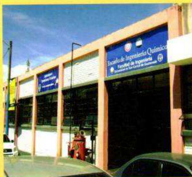
Instalaciones actuales de la Escuela de Ingeniería Química, Facultad de Ingeniería, USAC Edificio T-5
