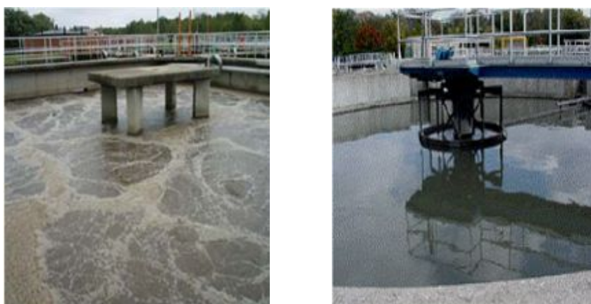
Figura 2. Clarificador Horizontal
